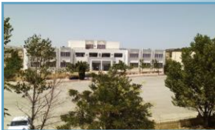
L'unité de recherche matériaux émergents
